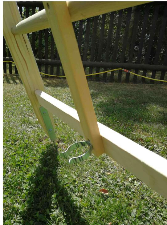
*Klemmsicherung für Pfahlstütze*
